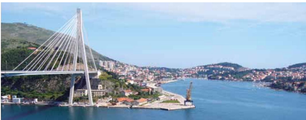
De Franjo Tuđman-brug in Dubrovnik, Kroatië.
