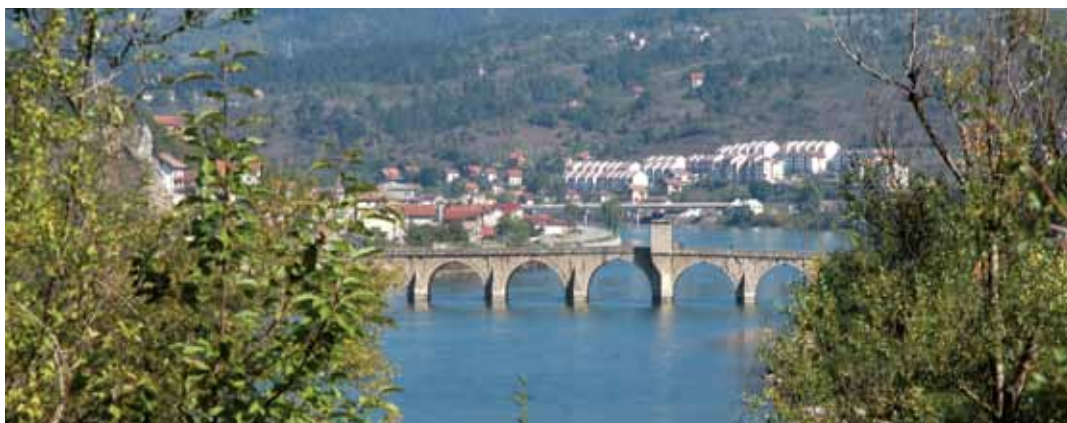
De Mehmed Paša Sokolović-brug over de rivier Drina in Bosnië en Herzegovina.
